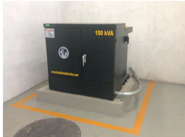
Transformador de 150 KVA
