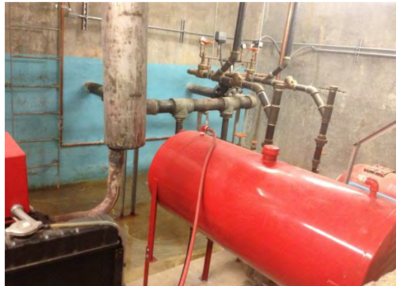
Equipo hidroneumático
