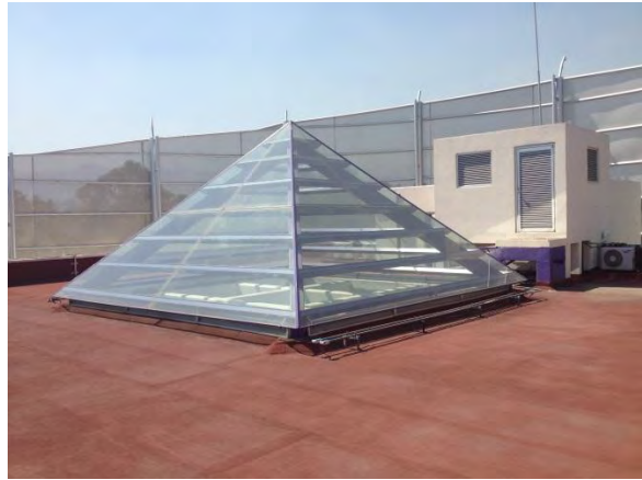
Domo piramidal y cuarto de máquinas del elevador
